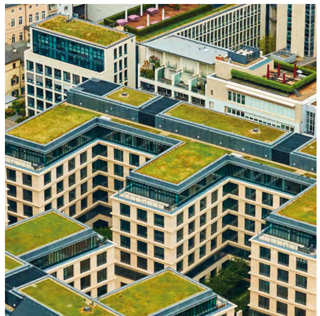
Dachbegrünungen in einem innerstädtischen Bürokomplex
