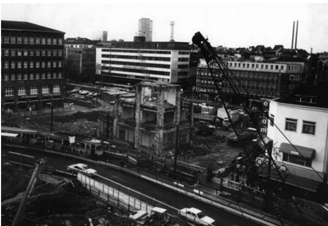
● Abb. 13 Abriss des Carsch-Hauses
