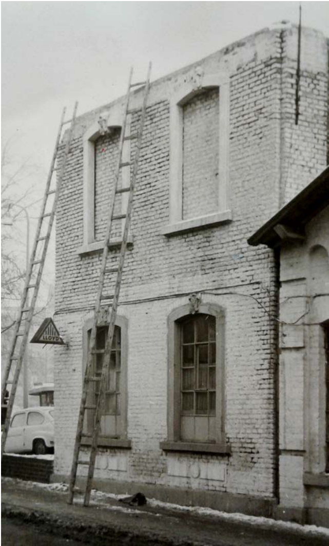
● Abb. 2 Sicherung von Fassadenteilen für die Denkmalpflege, Aachen Peterstraße 44–46 (1963)
