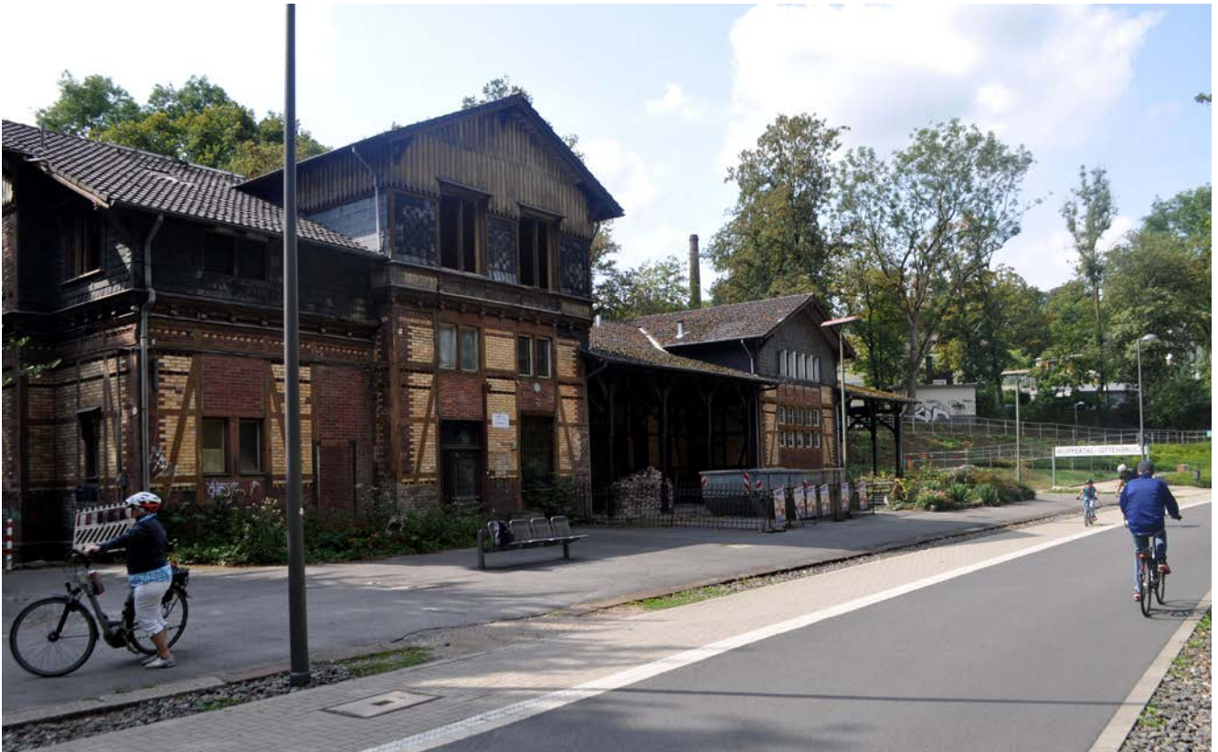
● Abb. 8 Wuppertal, Ehemaliger Bahnhof Ottenbruch vor geplanter Sanierung
