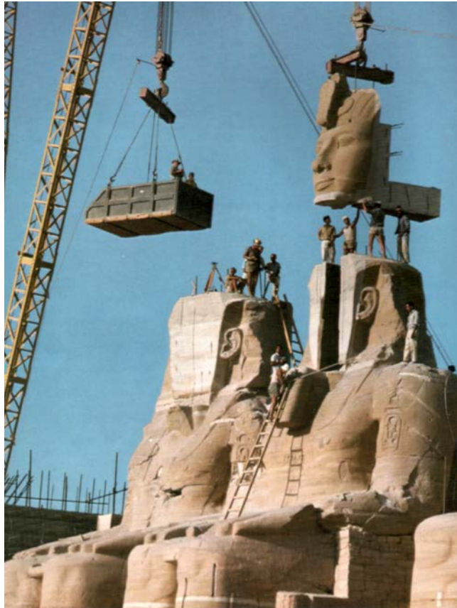
● Abb. 1 Die Versetzung der Tempelanlage in Abu Simbel
