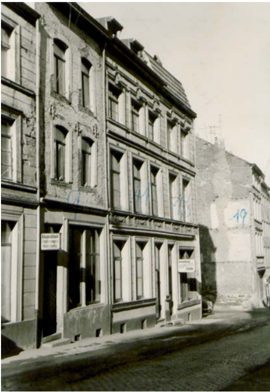
● Abb. 6 Häusergruppe im Sanierungsgebiet I vor dem Abbruch, Kockerellstraße Aachen
