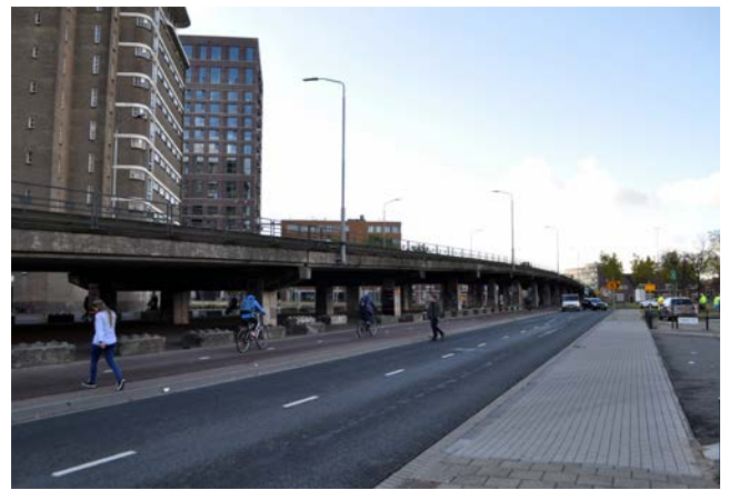
● Abb. 4 Eindhoven, Viaduct Beukenlaan
