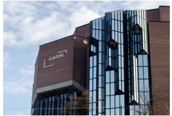
● Abb. 4 München, Gasteig, Architekten ARGE Raue, Rollenhagen, Lindemann, 1978–1984, Detail der bestehenden Fassade
