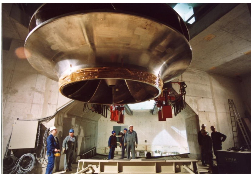
Abbildung 8: Einfahren des Laufrades einer Francis-Pumpturbine im Pumpspeicherkraftwerk Goldisthal
