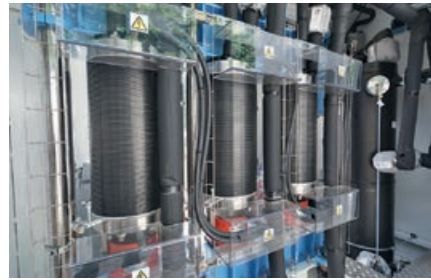
In Ibbenbüren betreibt die RWE ein Demonstrationsprojekt Power-to-Gas und zur Erforschung einer innovativen Elektrolyse.
